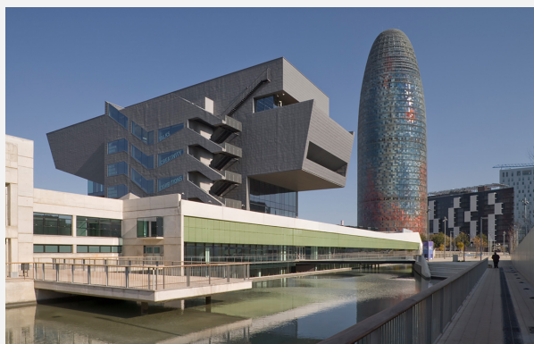
Edifici Disseny Hub Barcelona. Fotografia: Lourdes Jansana, Museu del Disseny de Barcelona.
