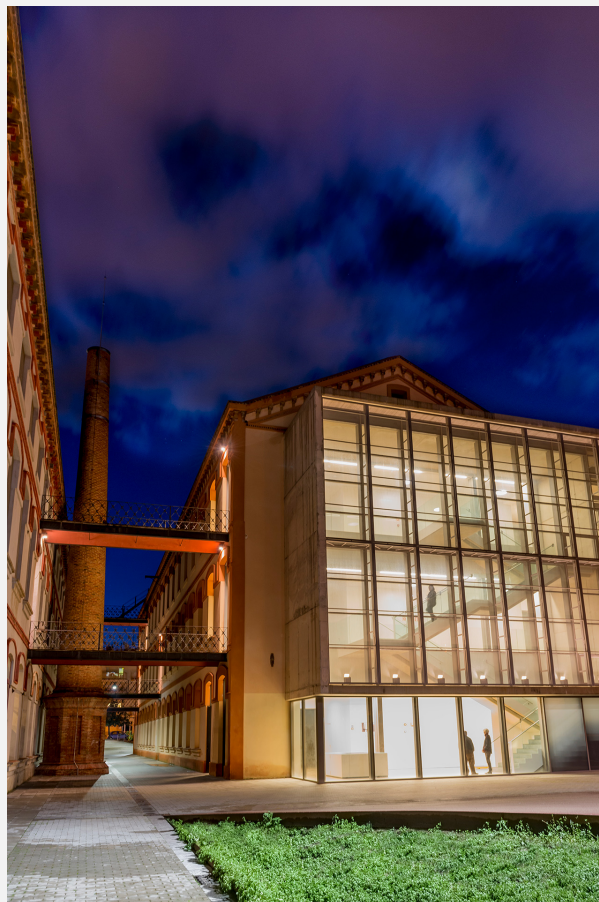
Façana de la nau petita de Can Marfà. Fotografia: Museu de Mataró.
