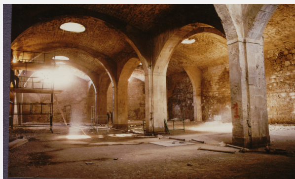
Dipòsits vells de Manresa durant la seva restauració, autor desconegut (Arxiu Fundació Aigües de Manresa. Junta de la Séquia)
