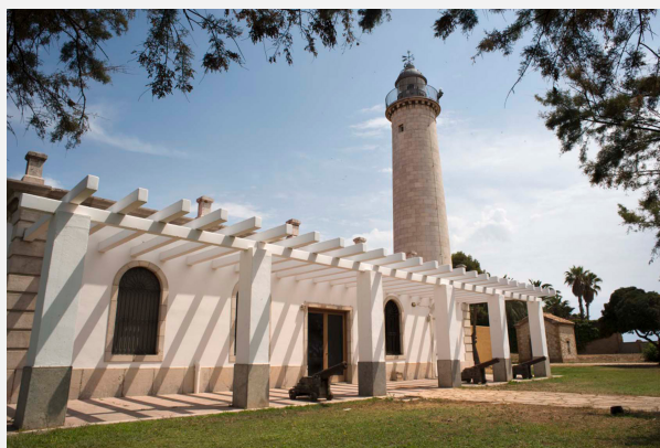
Fachada del Espai Far. Fotografía: Espai Far (Concejalía de Cultura Ayuntamiento de Vilanova i la Geltrú).
