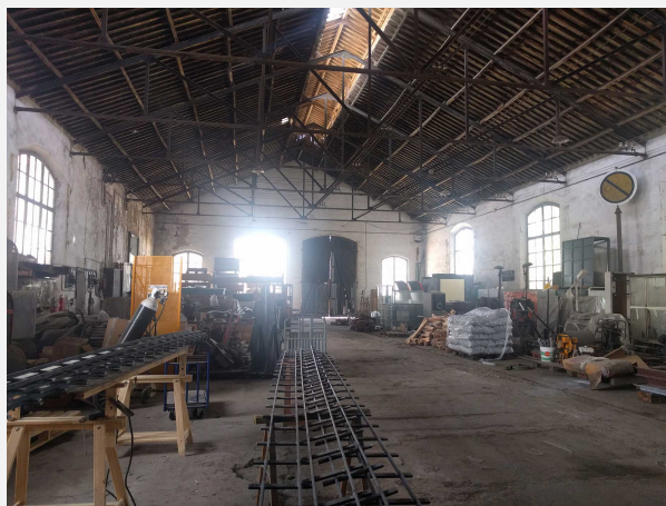
Nau gran de reparacions. Museu del Ferrocarril de Catalunya (2016) – Autora: Ana Requejo
