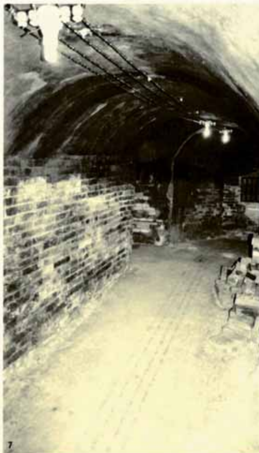
6 i 7. Interior del refugi 307. © de la fotografia: Jordi Montlló
